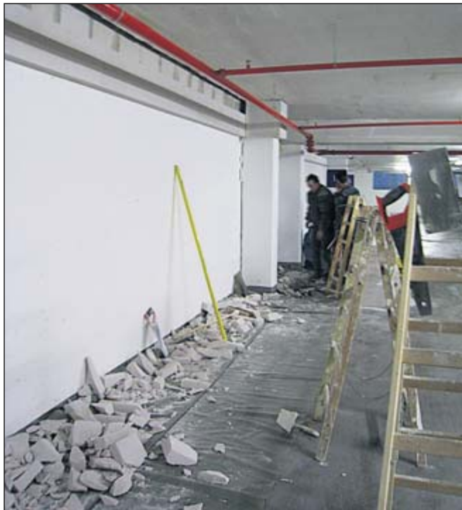
Weil die dünnen Bimssteine im Eingangsbereich zu den Havenwelten abplatzen, müssen sie nun ersetzt werden.
